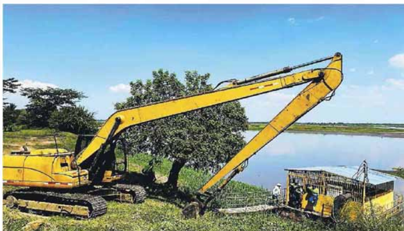
Los trabajos con maquinaria amarilla se pusieron en marcha ante el bajo nivel del río. | Foto: Cortesía
