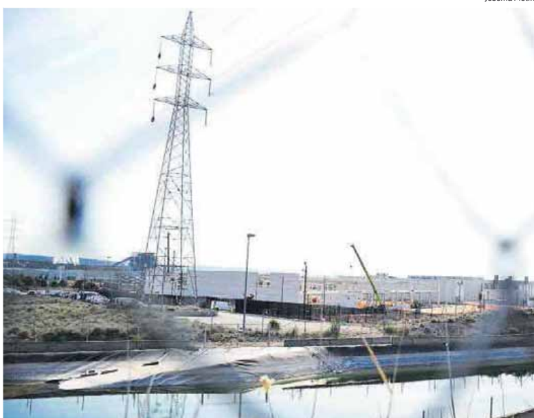
Un depósito de agua junto al centro de datos de Amazon Web Services en El Burgo de Ebro.
