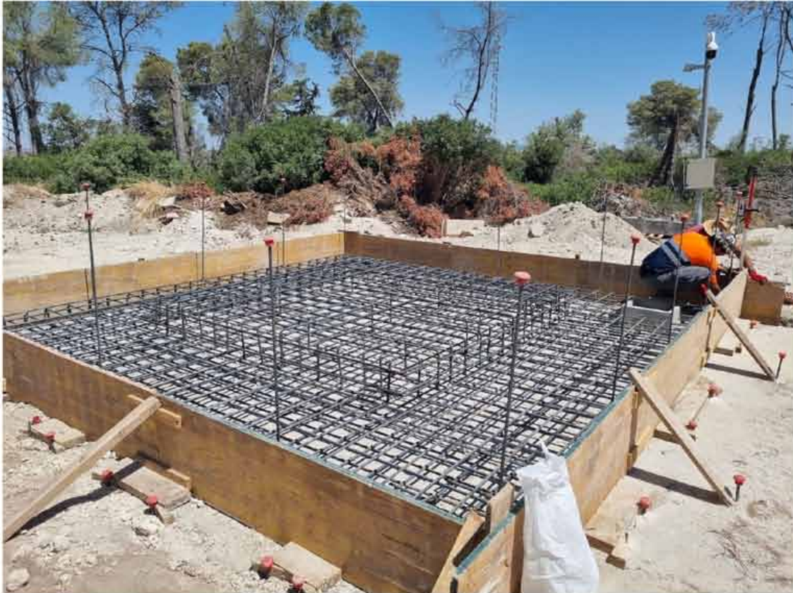
Obras hidráulicas en Jerez
