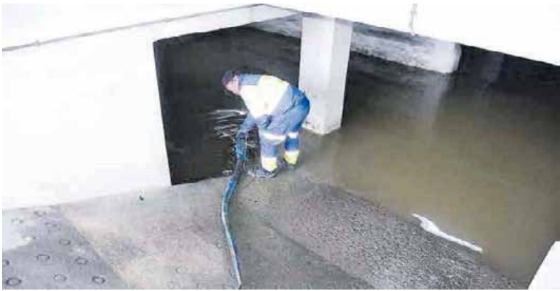
Uno de los operarios de Aqualia con una de las motobombas para achicar el agua de uno de los sótanos anegados ayer por la mañana en la calle Pazos Fontenla. | Gonzalo Núñez
