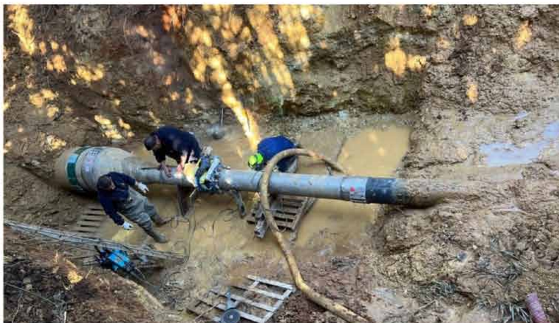
Renovación de válvula en la Hijaleta del Serrallo por parte del CAZG.
