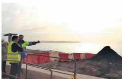
Trabajos ya en marcha en Costacabana. LA VOZ
