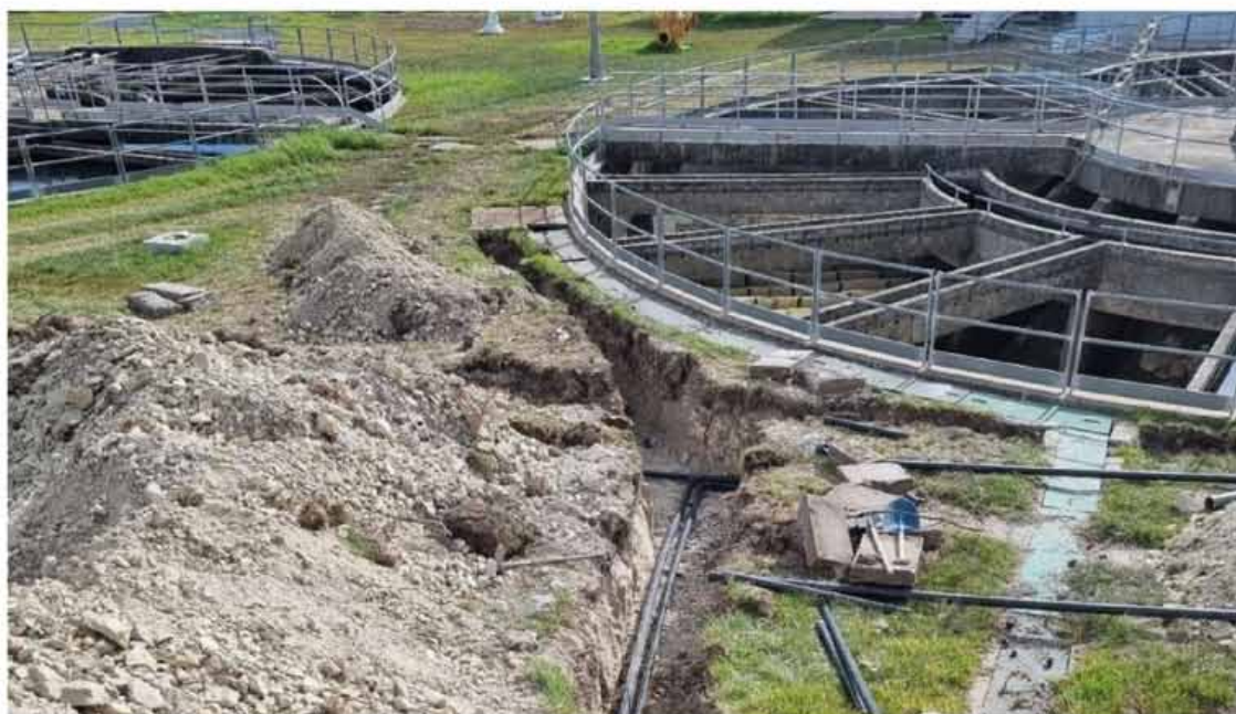
Mejoras en la depuradora de Cuartillos.
