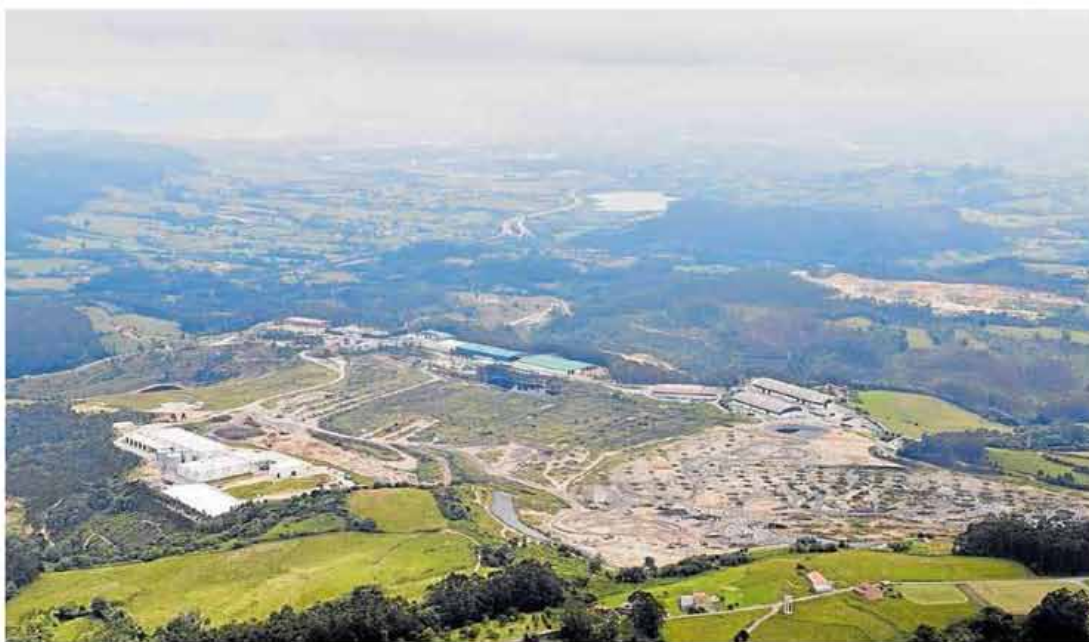
Vertedero central de residuos y naves alrededor que conforman el complejo de Cogersa en la intersección de Gijón, Llanera, Corvera y Carreño.
