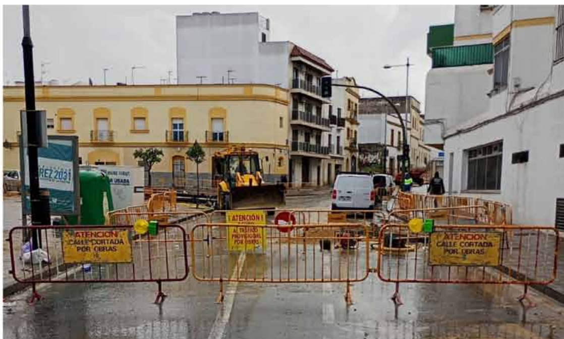
Obras de mejora en la red de aguas de Jerez, en la Ronda Muleros, realizada por Aquajerez.
